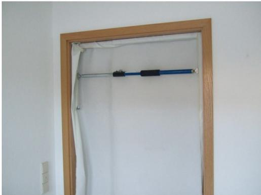
Der Einbau des Rauchverschlusses in Zugangstüren zu Brandräumen oder Wohnungseinheiten stellt sicher, dass nach Öffnung der Tür kein weiterer ...
